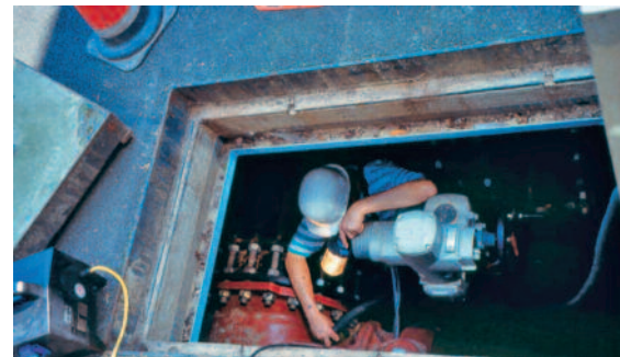
Abbildung 3: Handleuchte mit Schutzkleinspannung in einem leitfähigen Schachtbauwerk mit begrenzter Bewegungsfreiheit
