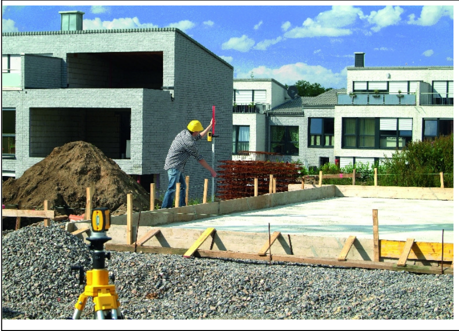
Abbildung 6: Linienlaser beim horizontalen Ausmessen mit einem Receiver
