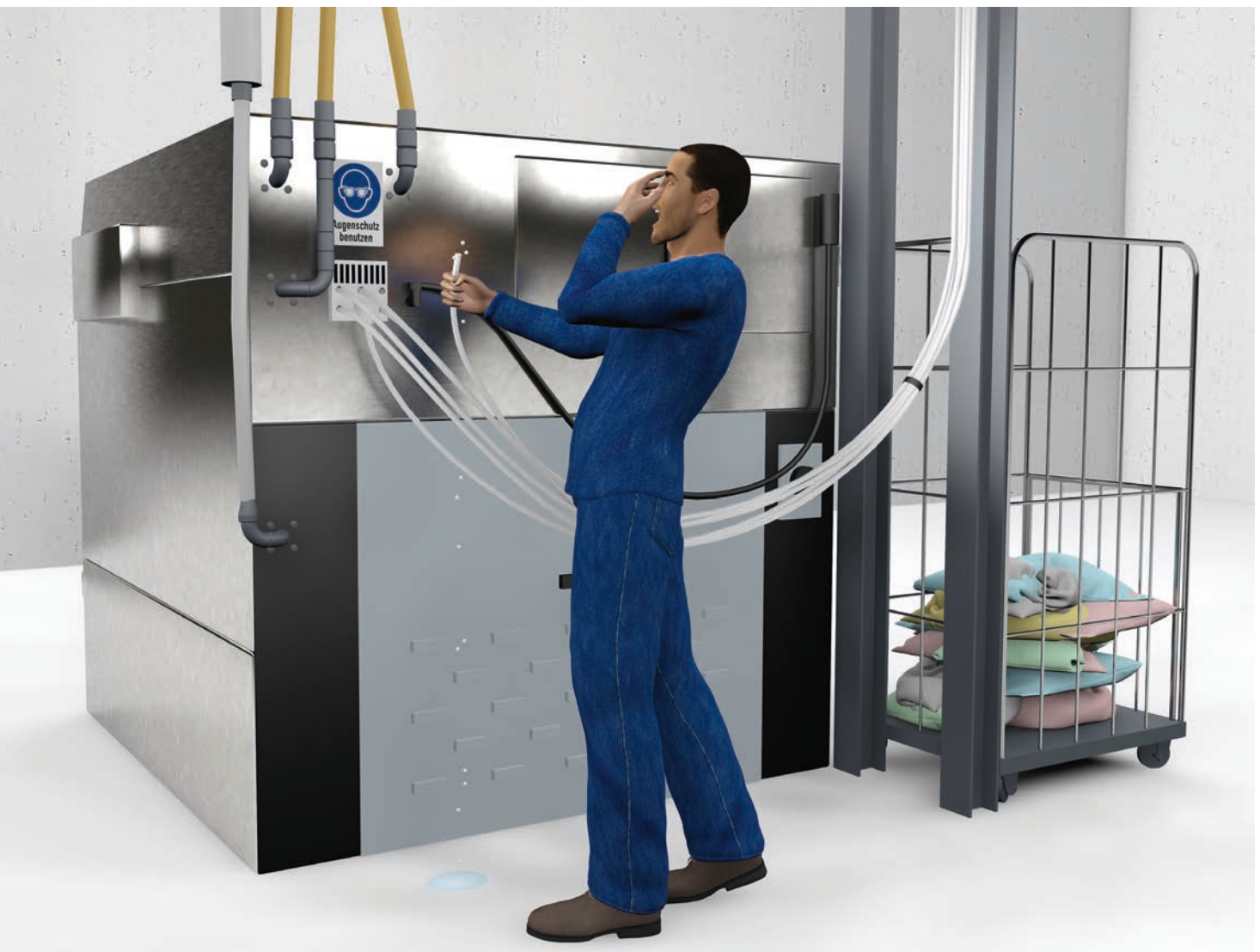
Die konzentrierte Kalilauge aus dem Schlauch der Dosieranlage verätzte das Auge eines Beschäftigten. Seine Sehfähigkeit blieb auf Dauer stark eingeschränkt.
