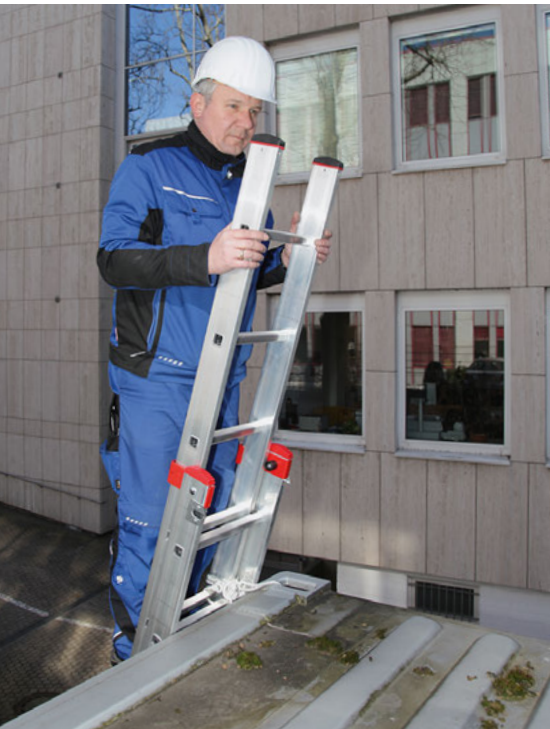
Anlegeleitern z. B. durch Festbinden am oberen Anlegepunkt gegen Verrutschen sichern.
