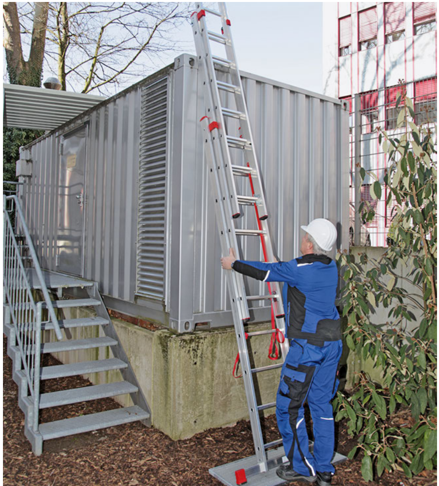
Als Aufstiegshilfen dürfen Leitern mit Sprossen weiter verwendet werden. Man sollte aber beim Anstellen auf tragfähigen Untergrund achten bzw. ihn mit Unterlagen schaffen.
