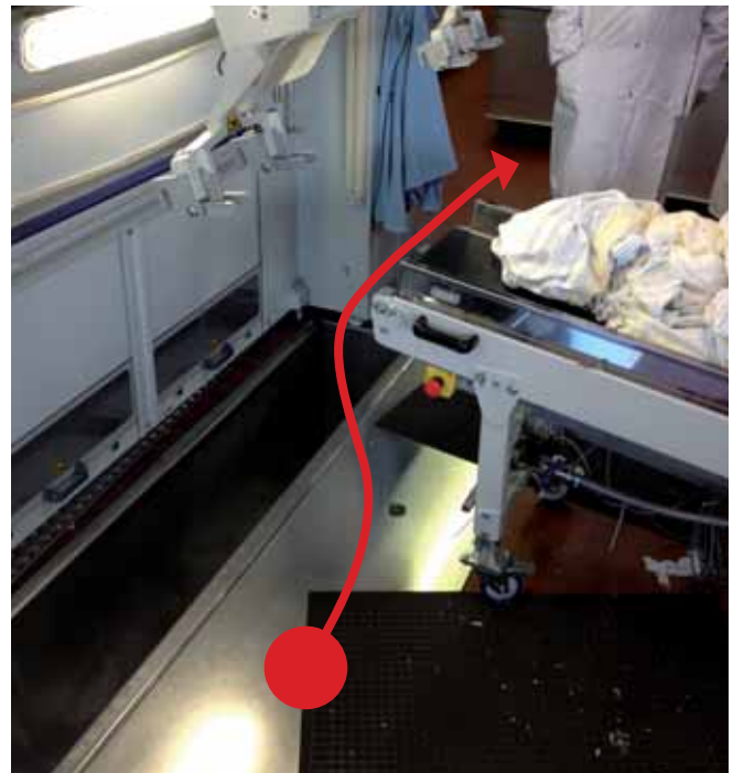
Der Versuch, sich zwischen Zuführband und Mangelgrube hindurch zu quetschen, endete zweimal mit schweren Verletzungen.
