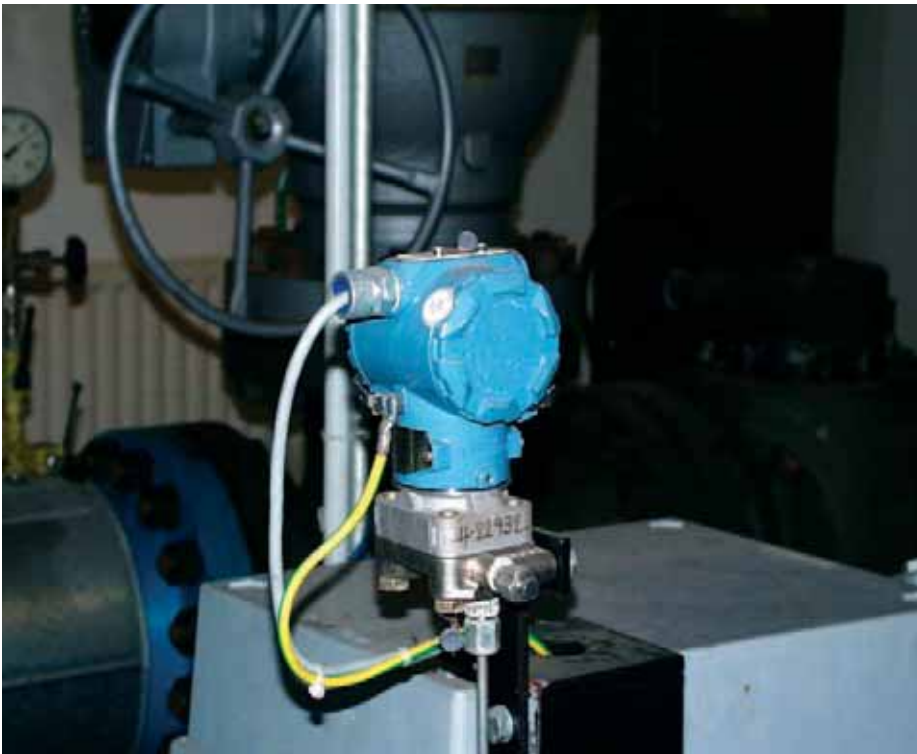
Drucktransmitter, Zündschutzart Eigensicherheit
