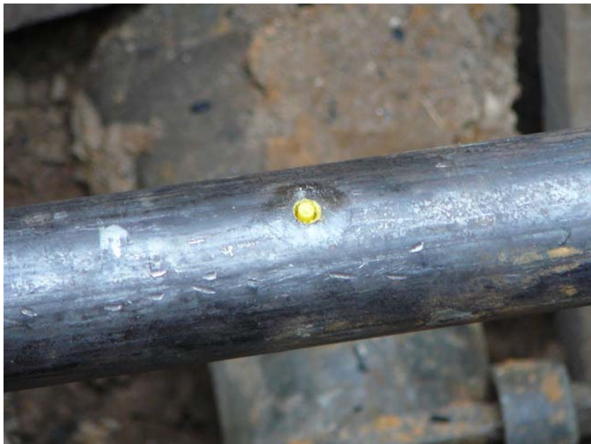
Entwicklung und Erprobung eines neuen Verfahrens zur Abtrennung von Gas-Hausanschlussleitungen unter Verwendung von Polymerschäumen
