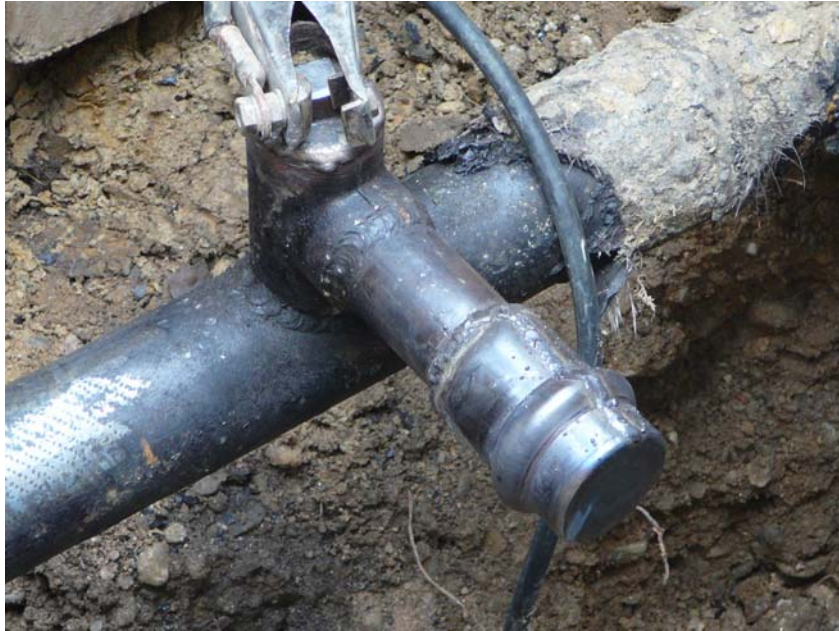
Entwicklung und Erprobung eines neuen Verfahrens zur Abtrennung von Gas-Hausanschlussleitungen unter Verwendung von Polymerschäumen
