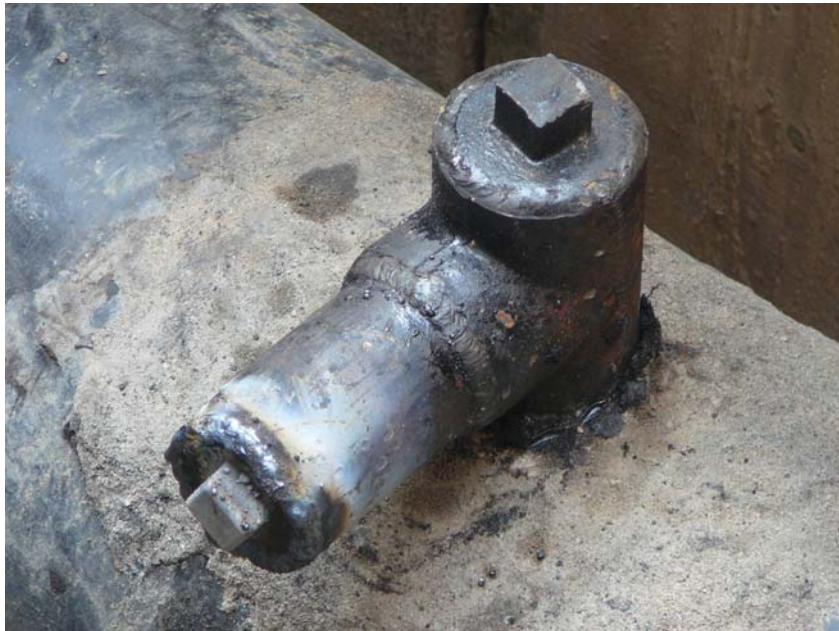
Entwicklung und Erprobung eines neuen Verfahrens zur Abtrennung von Gas-Hausanschlussleitungen unter Verwendung von Polymerschäumen
