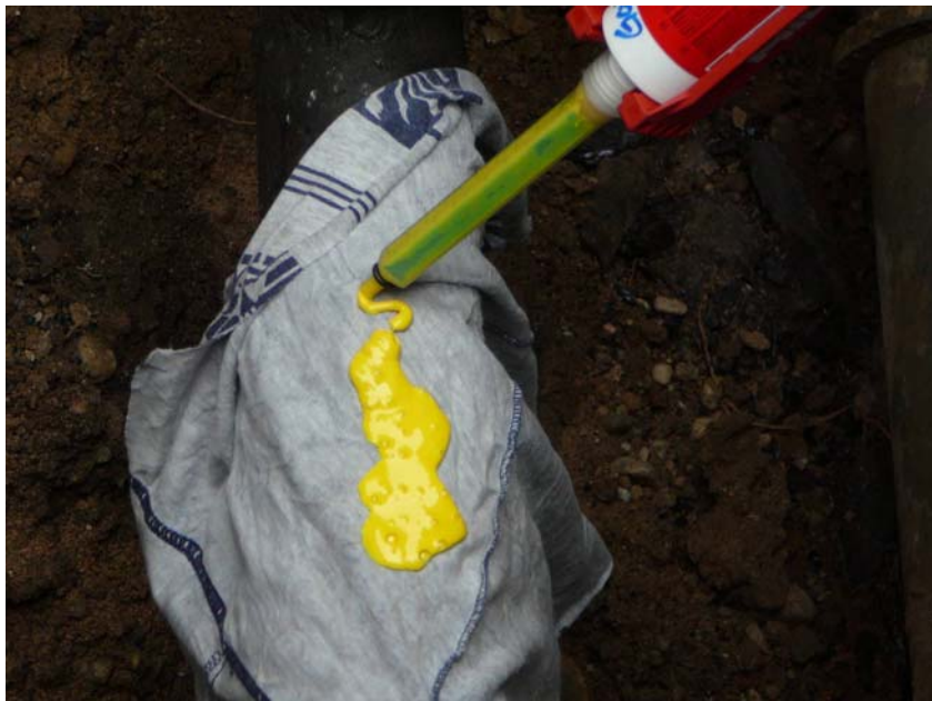
Entwicklung und Erprobung eines neuen Verfahrens zur Abtrennung von Gas-Hausanschlussleitungen unter Verwendung von Polymerschäumen
