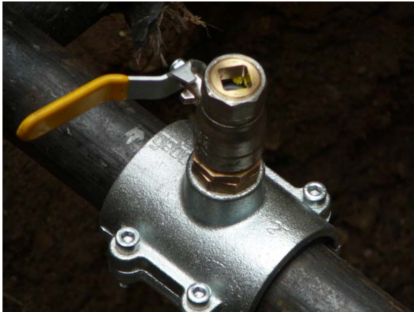
Entwicklung und Erprobung eines neuen Verfahrens zur Abtrennung von Gas-Hausanschlussleitungen unter Verwendung von Polymerschäumen
