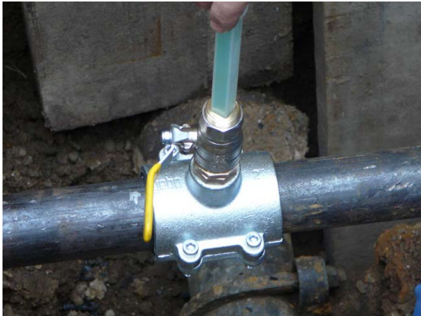
Entwicklung und Erprobung eines neuen Verfahrens zur Abtrennung von Gas-Hausanschlussleitungen unter Verwendung von Polymerschäumen
