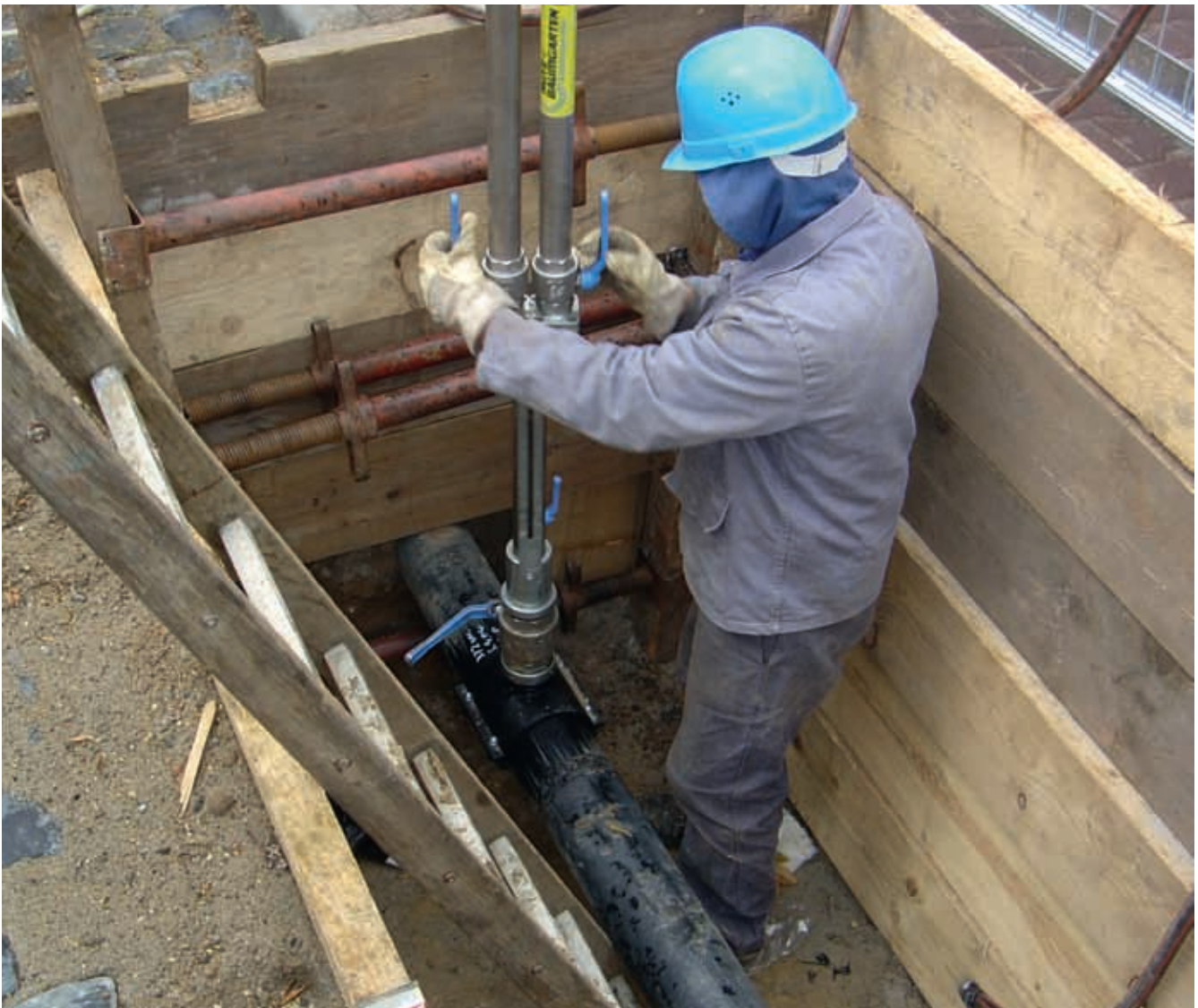
Arbeiten an Gasleitungen
