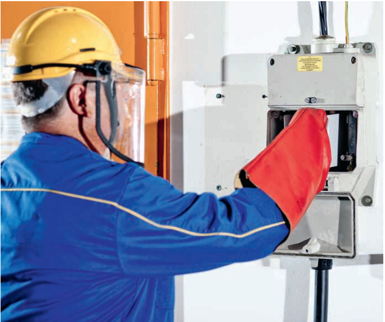
Arbeiten am Hausanschlusskasten
