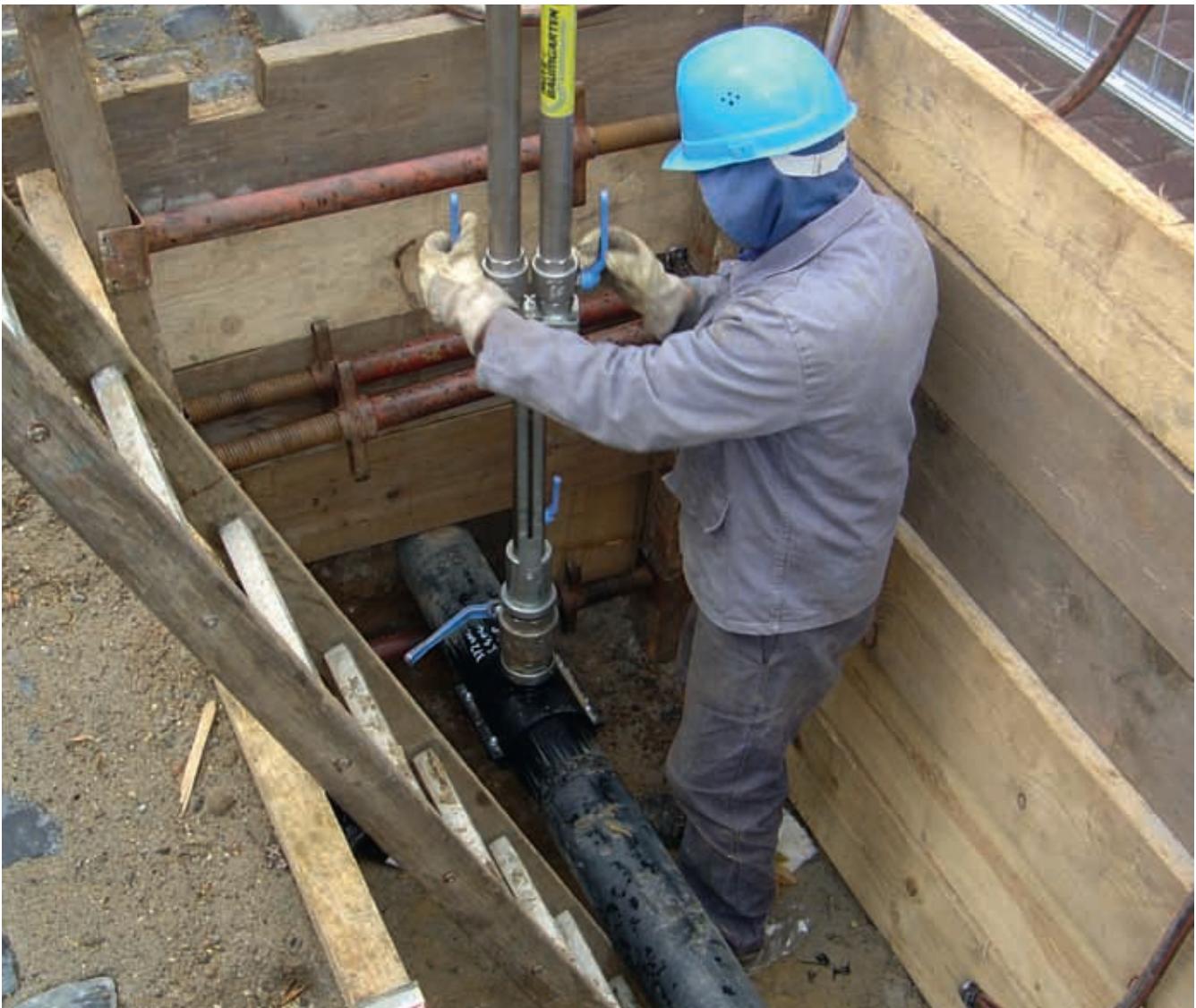
Arbeiten an Gasleitungen
