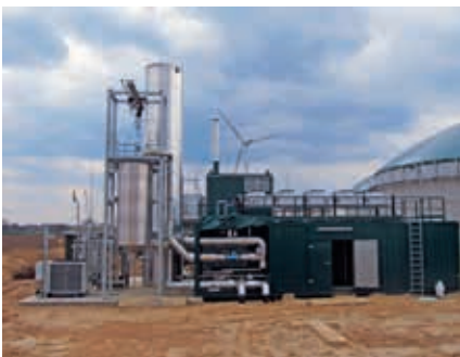
Für jede Anlagenkomponente – hier ein Gasverdichter (oben) und eine Aminwäschanlage (unten) – kann der Anlagenbetreiber mit der EX-RL-Beispieltabelle die Explosionsschutzmaßnahmen festlegen.
