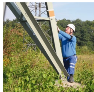
Freileitungsmonteur bei Markierungsarbeiten
