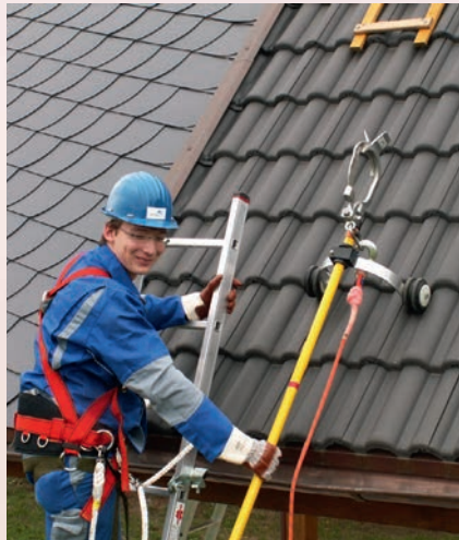
Bei Arbeiten an einem Dachständer auf einem Satteldach nutzt der Mitarbeiter Persönliche Schutzausrüstung gegen Absturz sowie eine Sicherungsstange mit Rollenfahrwerk.
