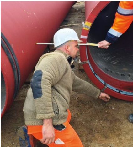
Abb. 4: Um den tatsächlichen Platzbedarf zu ermitteln, sollte der Unternehmer die geplanten Arbeiten im Vorfeld simulieren.
