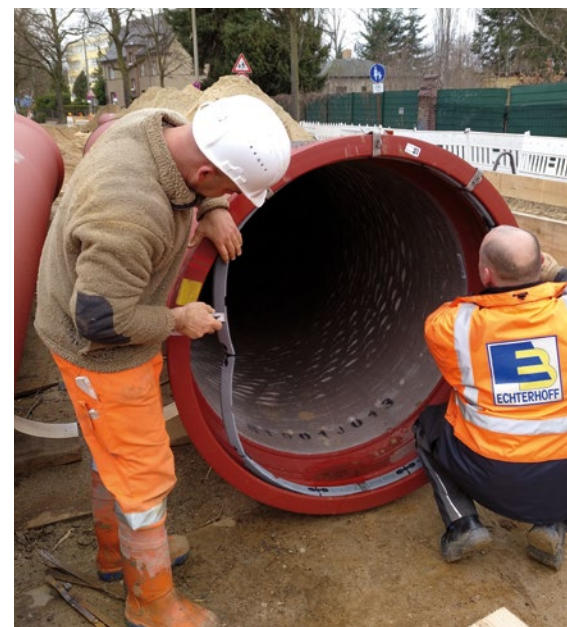
Abb. 3: Klammern zur Fixierung des Dichtrings. Diese müssen nach der Rohrmontage auch wieder entfernt werden.
