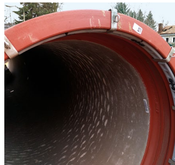
Abb. 3: Klammern zur Fixierung des Dichtrings. Diese müssen nach der Rohrmontage auch wieder entfernt werden.
