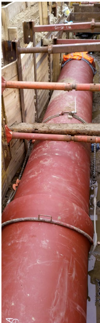
Abb. 1: Rohrleitung mit Kettenzug zusammengezogen
